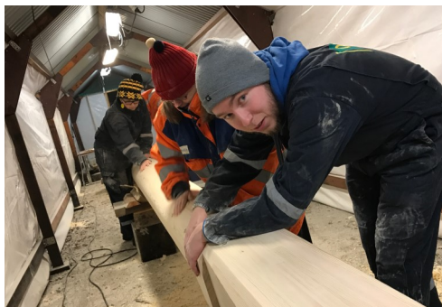
Slipning av nya masten
