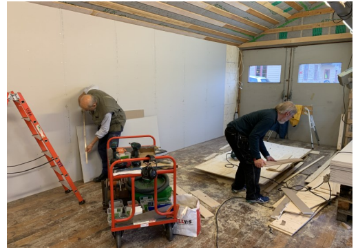
Volontärer bygger på nya motorboden dagtid
