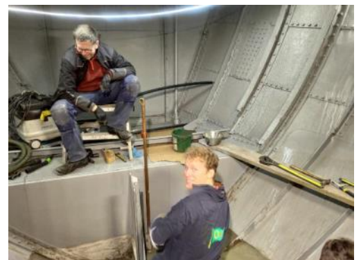
Gjutning av betong—inne i skansen
