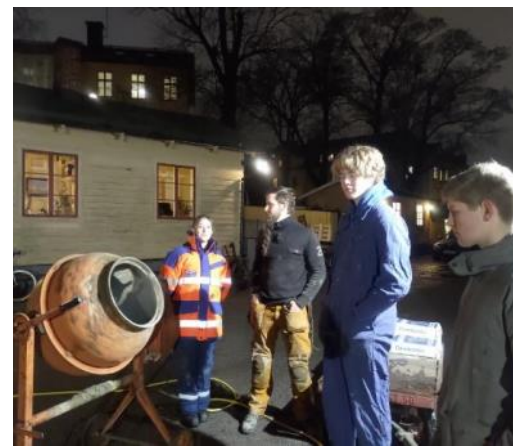
Gjutning av betong—utomhus
